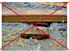
Zet de draagbalken niet in beton vast
