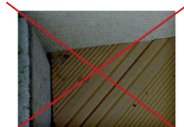
Houd een expansieruimte van 5 mm tussen de planken en 15 mm van de muur
